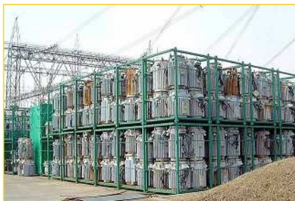
(PCB入りのため廃棄を待つ東京電力のトランス)
